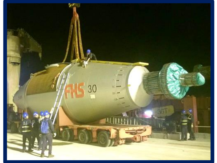
Tiếp nhận, vận chuyển và bàn giao 20 kiện hàng STST từ Cảng Sơn Dương đến công trường Dự án Formosa Hà Tĩnh
