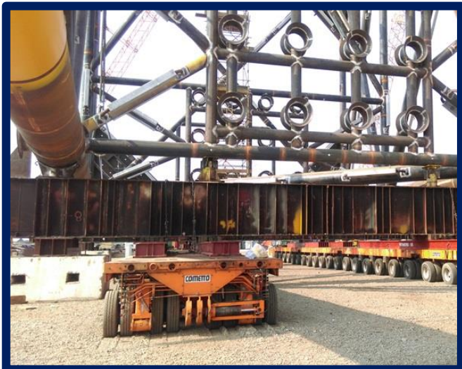
Di dời và hạ thủy thành công kiện Jacket RC9 (nặng 950 tấn; kích thước: D.52 x R.25 x C.22m) từ vị trí chế tạo xưởng sà lan tại Cảng VietSovpetro – Thành phố Vũng Tàu.
