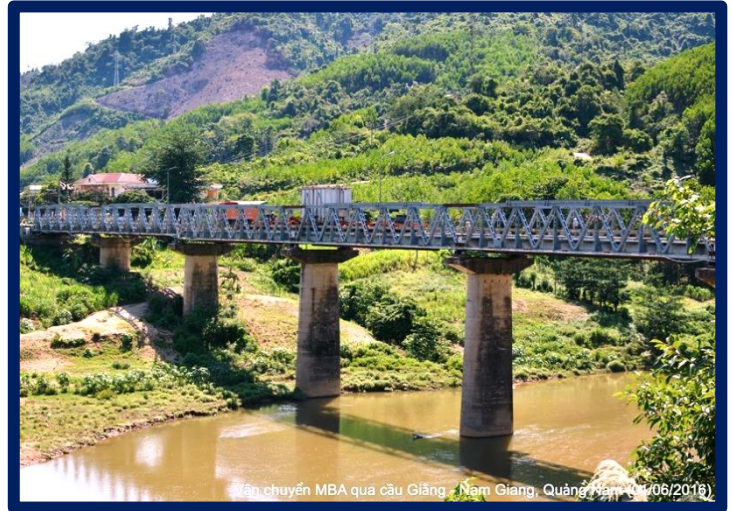
Vận chuyển và bàn giao toàn bộ 03 thân máy biến áp nặng 115 tấn/máy từ Trạm biến áp 500KV Thường Tín, Hà Nội đến trạm biến áp 500KV Thạnh Mỹ, Tỉnh Quảng Nam.
